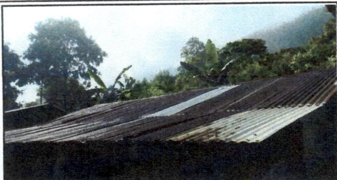
Foto1: Sustitucion de laminas acanaladas por laminas troqueladas
