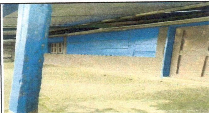
Foto 3: Sustitucion de puertas y ventanas de madera por metal
