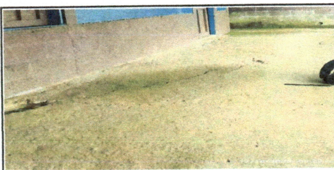
Foto 5: Sustitucion de piso de torta por ceramico
