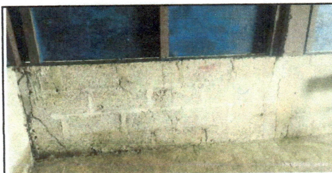
Foto 6: Seguimiento del levantamiento de block
